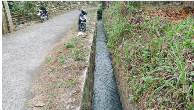
Gambar 3 Saluran Pembawa DI Jaten
