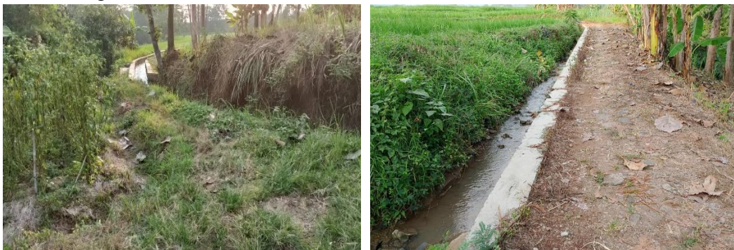
Gambar 6 Jalan Masuk/Jalan Inspeksi DI Jatén
